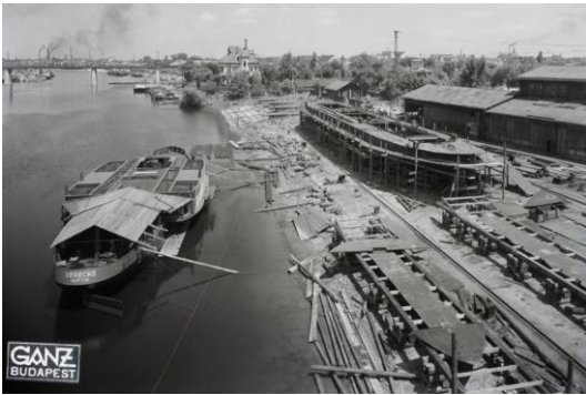
Újpesti-öböl, Ganz és Tsa. Villamossági-, Gép-, Waggon- és Hajógyár Rt. Az MFTR Verecke (1939) oldalkerekes gőzhajó építése.
