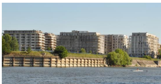
a terület déli szakaszán lévő függőleges és rézsűs vasbeton partfal, háttérben a megújuló városrész forrás: saját fotó
